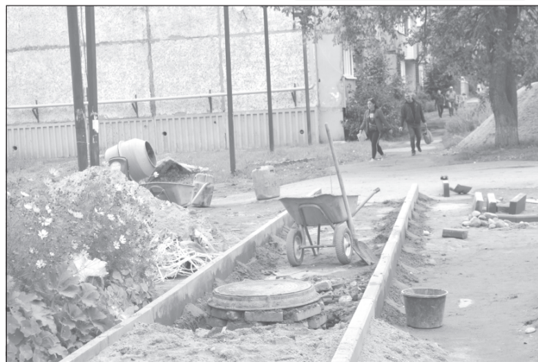
Идёт строительство тротуара по ул. Революционной
